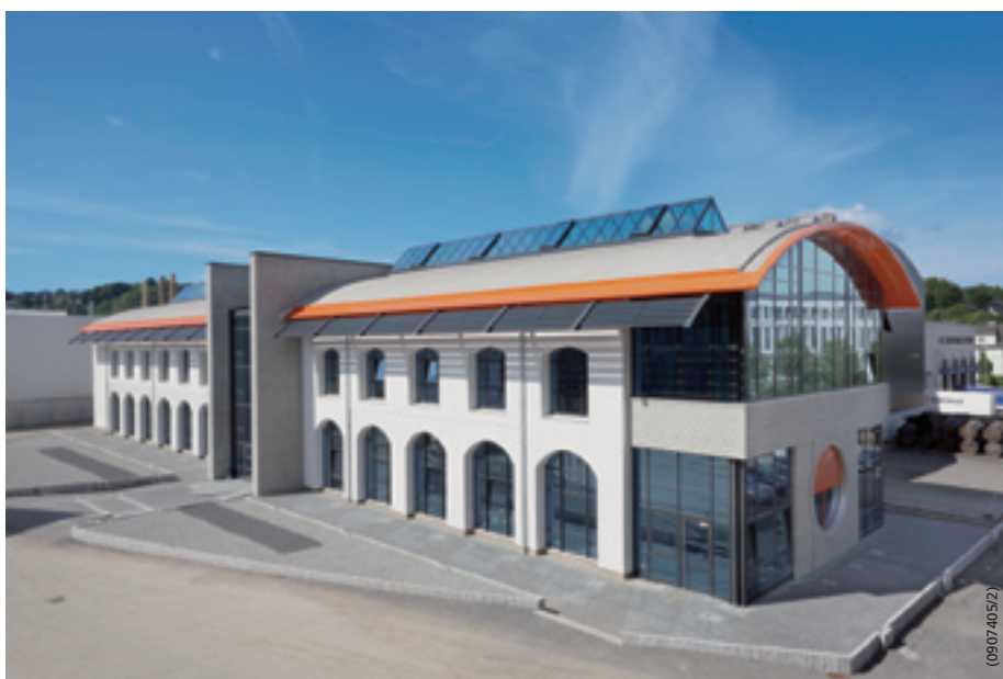
Im neuen Verwaltungsgebäude in Wetter sind auch das neue Ausbildungszentrum des Unternehmens sowie ein modernes Prüflabor untergebracht.
