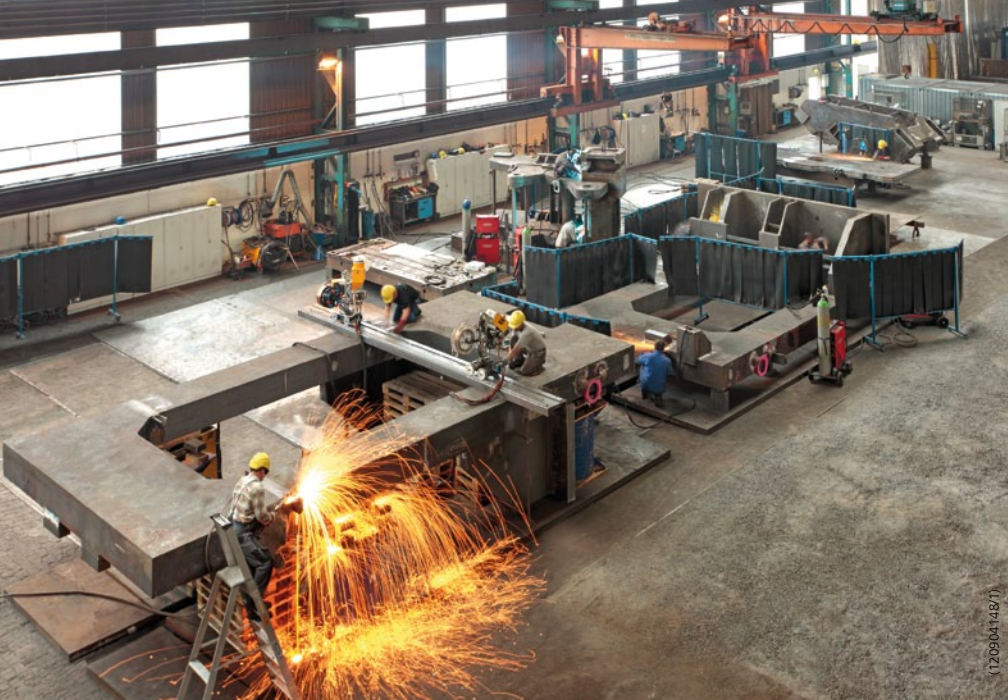
Der Schweißbetrieb am Essener Standort des Unternehmens (Fotos: von Schaewen)
